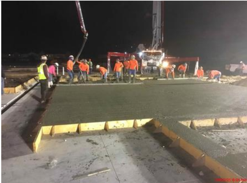
Early Morning Pour of Tilt Panels
